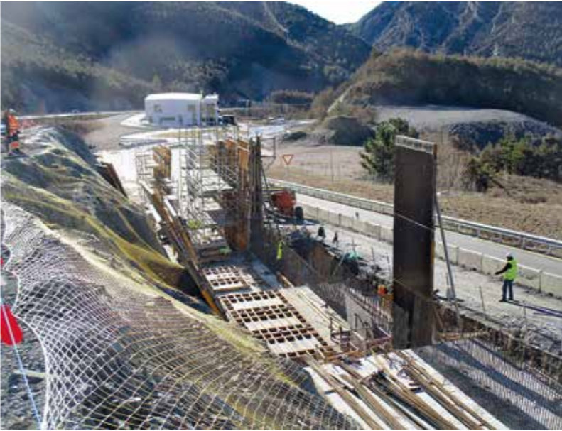
En las fotos superiores, se puede observar como otra de las actuaciones más destacadas ha sido la estabilización de laderas con muros de contención y malla metálica para evitar desprendimientos de material.
