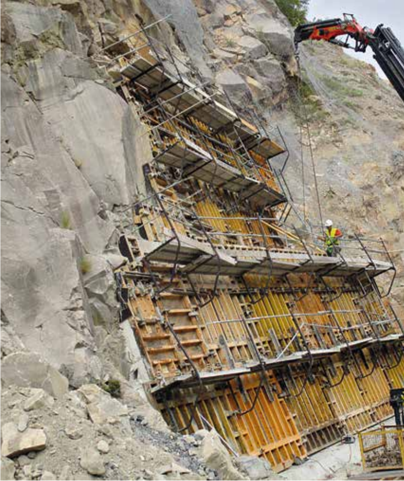
En las fotos superiores, se puede observar como otra de las actuaciones más destacadas ha sido la estabilización de laderas con muros de contención y malla metálica para evitar desprendimientos de material.
