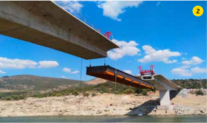
1/2. La estructura metálica del tramo central se transportó flotando y luego se izó 20 metros hasta su lugar. 3. Equipo de Ineco de asistencia técnica de control y vigilancia de las obras; de izqda. a dcha.: José Luis Domínguez, Joaquín Muñoz, Jesús González, Enrique Tristán y Manuel Martín.
