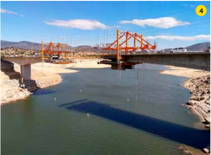
4. En el puente nuevo se ha utilizado la técnica constructiva de avance en voladizo en el tramo central y cimbras en los laterales, mientras que en el histórico (5) se empleó un sistema de autocimbra rígida.
